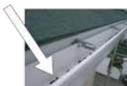
EやねかわらROOFは長期にわたり美観を維持することのできる確かな屋根材です。しかし製造工程上、製品には「製造時の石粒の付きムラ」があります。これは製品の規格以上に付着した石粒です。施工完了後から約6ヶ月～12ヶ月程度、写真のように雨樋やカーポットの屋根に少量の石粒が落ちてくる場合がありますが、この石粒は雨樋を詰まらせたり石粒が剥がれて本来の耐久性を損なう性質のものではありません。ご了承の上で採用頂くことをお願い申し上げます。
