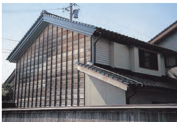
●写真-1 日本の気候風土に適した伝統工法「押し縁下見板」
