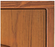
②上部の前倒れを防ぐため、横棒に上枠を載せたさねつぎ仕上げ
