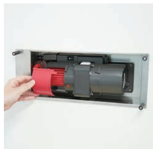
③ファンカバーの取り外し
